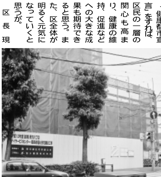
建設中の野方六丁目高齢者福祉住宅
