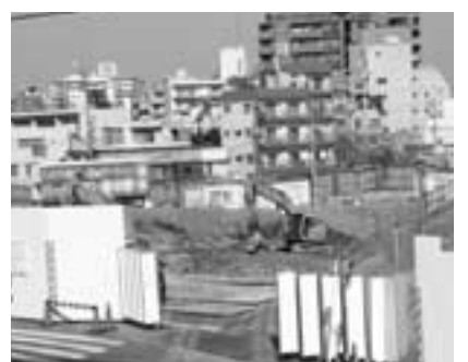
マンション建設現場
