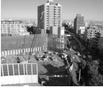
環七地下調節池工事
