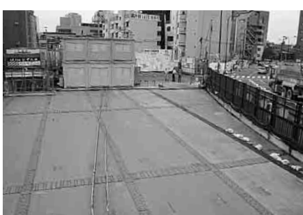
東中野駅前の工事中の人工地盤
