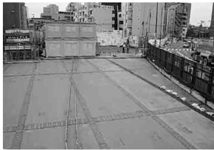
東中野駅前の工事中の人工地盤
