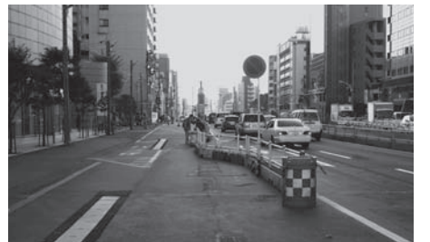
拡幅工事中山手通り
