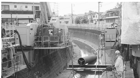
妙正寺川改修工事
