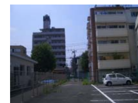
E：敷地内より南側
