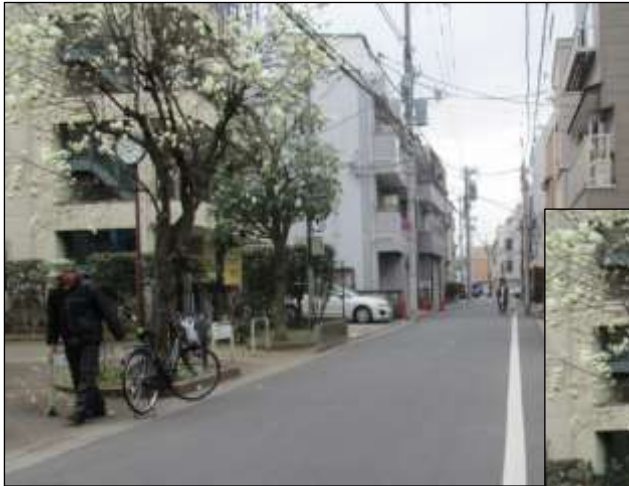
【現況写真】「無電柱化整備前（区道 12-910）」 弥生町三丁目
