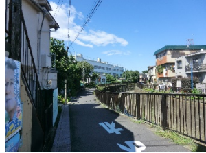
②北側道路(妙正寺川沿い)
