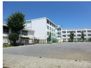
⑪体育館と校舎
