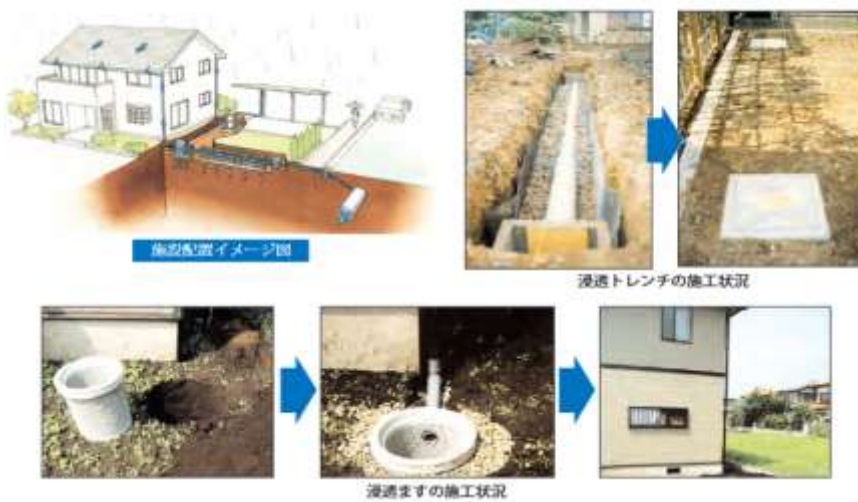
図 6-6. 浸透トレンチと浸透ますの施工
