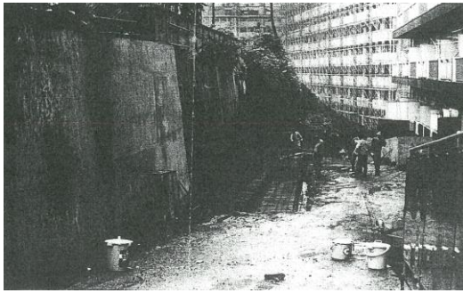
(1) 昭和 40 年当時の施工写真 (全景)
