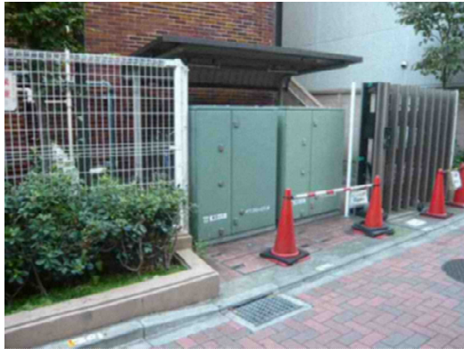
【公共用地への地上機器設置事例】
