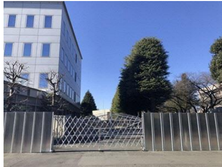
②東側道路
