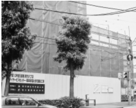
建設中の野方六丁目高齢者福祉住宅
