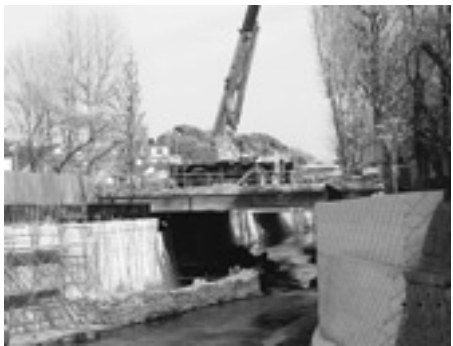
河川拡幅工事中
