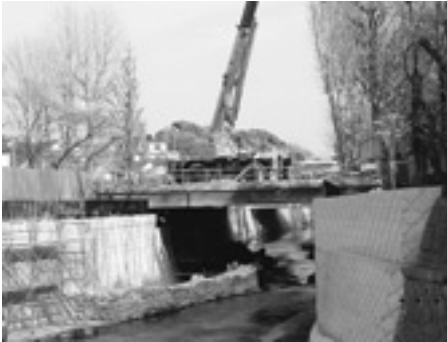
河川拡幅工事中
