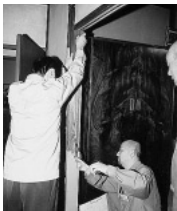
木造住宅の耐震診断
