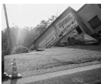
新潟県中越地震被災地
