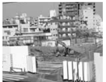
マンション建設現場
