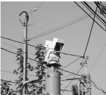
河川監視カメラ
