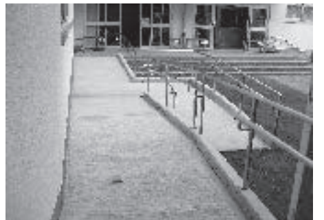
学校に設置されたスロープ
