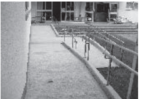
学校に設置されたスロープ
