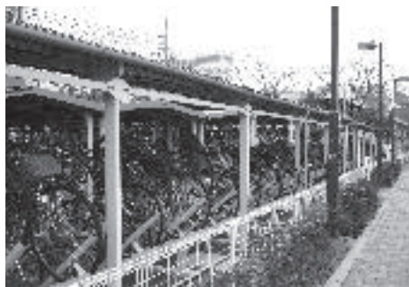
中野駅北口の自転車駐車場
