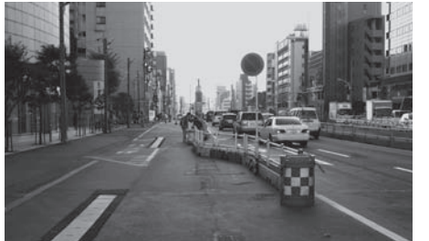
拡幅工事中の山手通り
