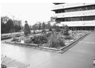
区役所の屋上緑化見本園
