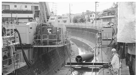
妙正寺川改修工事
