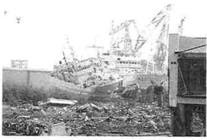
津波の被害を受けた東松島市
