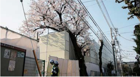
工事が進む(仮称)橋場保育園新園予定地
