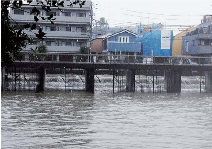
江古田の森公園調節池（流入時）
