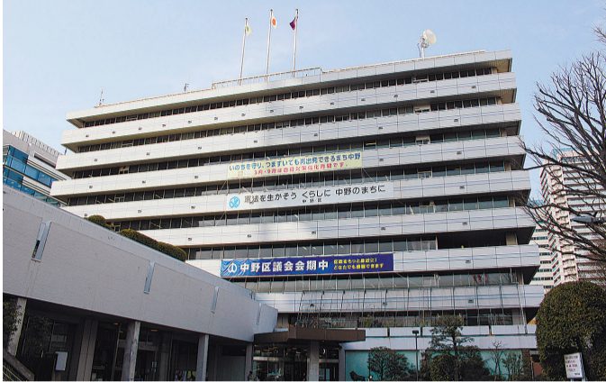
新庁舎移転に当たり閉庁予定の現中野区役所本庁舎
