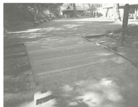
図 I-9：取り外しができる段差解消スロープ
