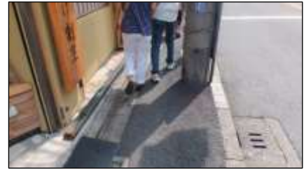
【幅員の狭い歩道】
