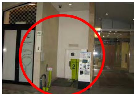
写真4-1 全自動地下駐輪場の入口（受渡し口）
