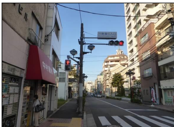
図 2-7 道路標識（地点名標識—共架）
