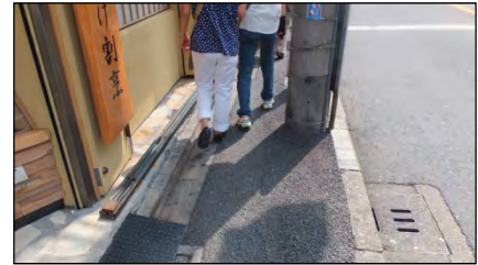
【幅員の狭い歩道】
