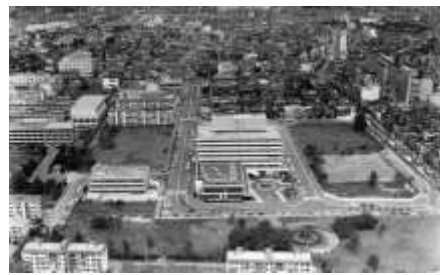
昭和43年 区庁舎竣工時の航空写真
