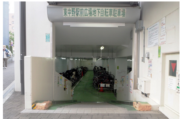
東中野駅前広場地下自転車駐車場
