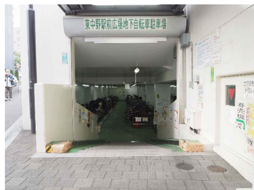
東中野駅前広場地下自転車駐車場
