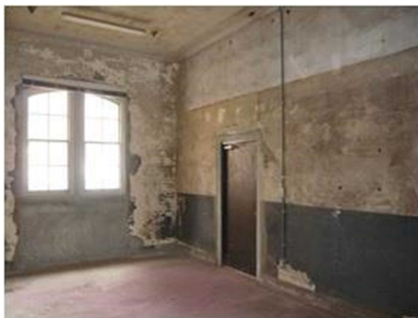
写真12 西側部屋内部（南側から）
