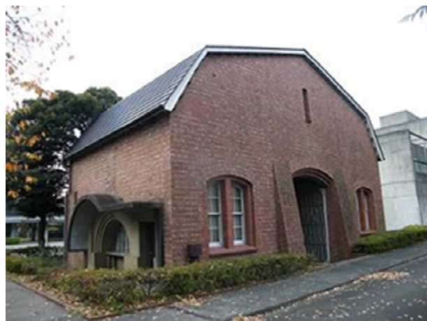
写真2 裏西側（北東側から）
