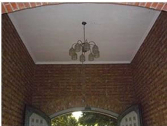
写真7 中央通路天井部分（北側から）
