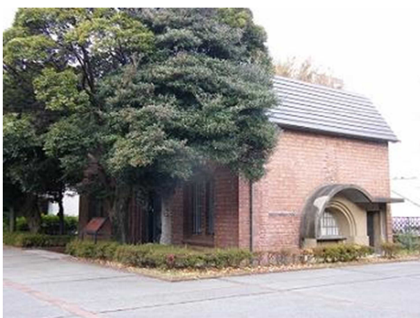
写真1 正面側（南東側から）
