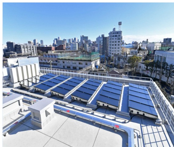
清掃事務所南中野事業所(太陽熱設備の導入例)
