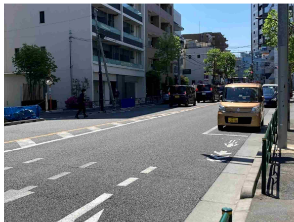
図 3.23 区内のパーキング・メーター周辺の整備状況（車道混在）
