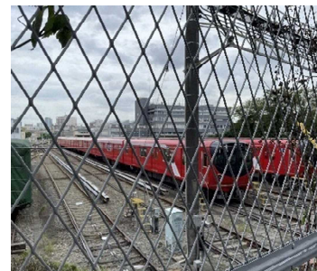
地下鉄車両基地
