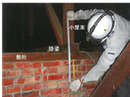
写真2 小屋組調査の様子
