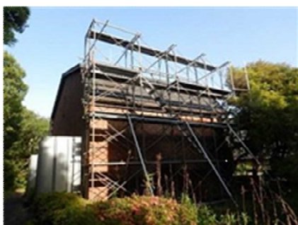
写真1 外部調査用足場設置の様子
