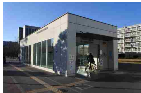
中野四季の森公園地下自転車駐車場
