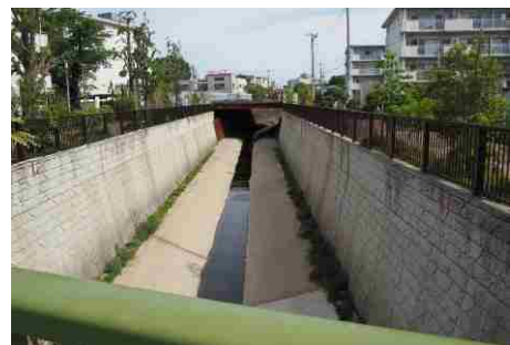
妙正寺川河川改修（若宮地区）
