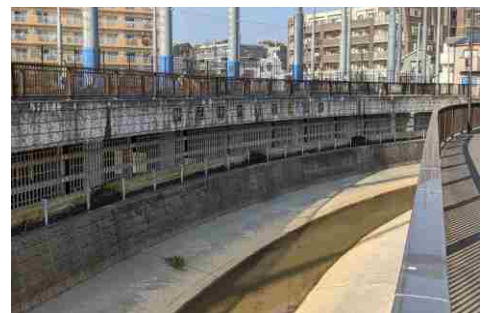
妙正寺川鷺宮調節池
