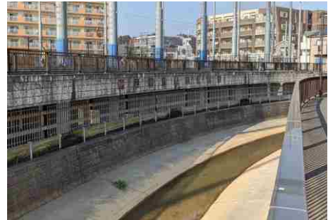
妙正寺川鷺宮調節池
