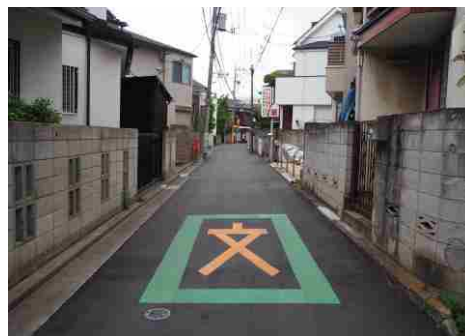
ブロック塀が続く生活道路
