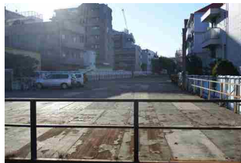
神田川の改修工事
