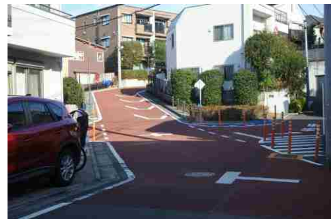
区画道路(平和の森公園周辺)
