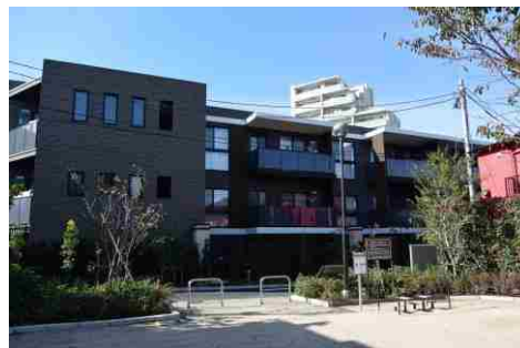
住宅地内の集合住宅（東中野三丁目）
