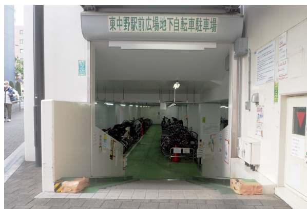
東中野駅前広場地下自転車駐車場
