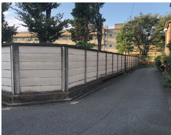
⑦南側道路(敷地中央付近)
