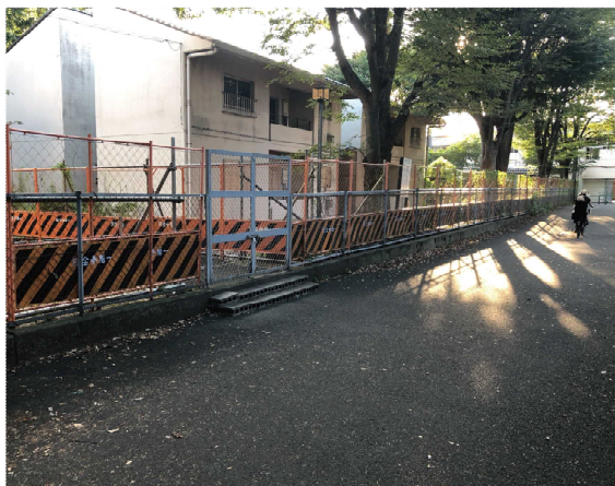
①北側下水道局管理通路
