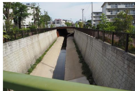
妙正寺川河川改修（若宮地区）
