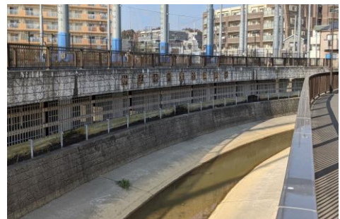
妙正寺川鷺宮調節池
