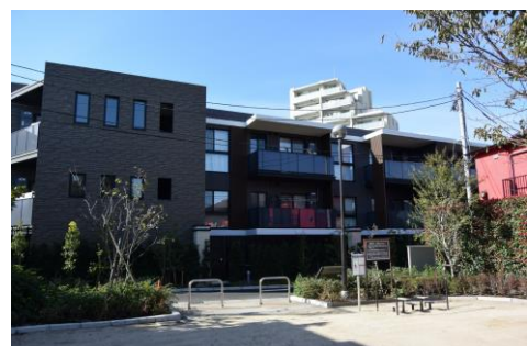
住宅地内の集合住宅（東中野三丁目）
