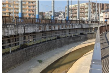
妙正寺川鷺宮調節池
