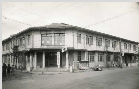
昭和 11 年から昭和 43 年まで使用した旧区役所庁舎
