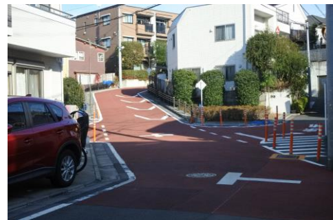
区画道路(平和の森公園周辺)
