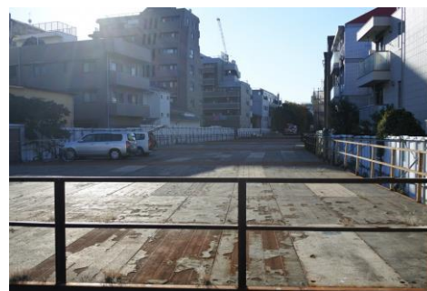
神田川の改修工事
