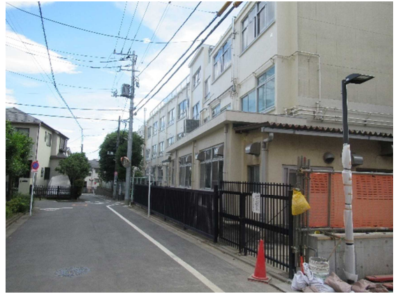
⑥東側敷地 北東角の給食室と搬入用入口
