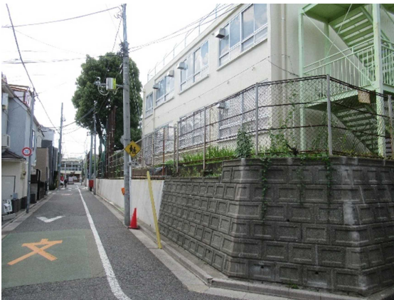
⑤東側敷地 南東角から南面道路を望む
