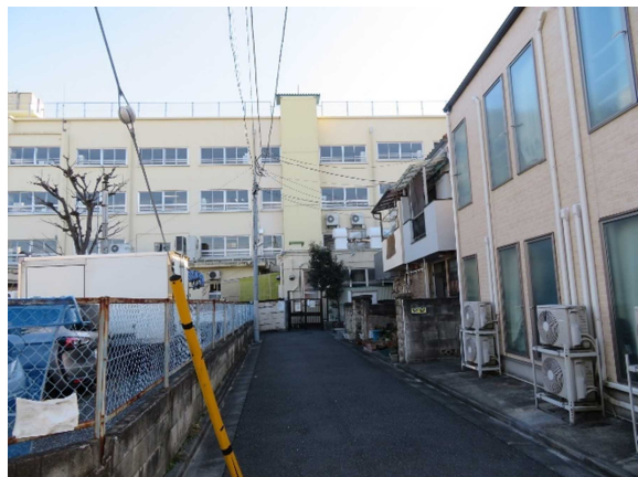
⑨北側道路(中央付近)
