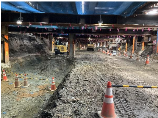
沼袋駅部 掘削工事
