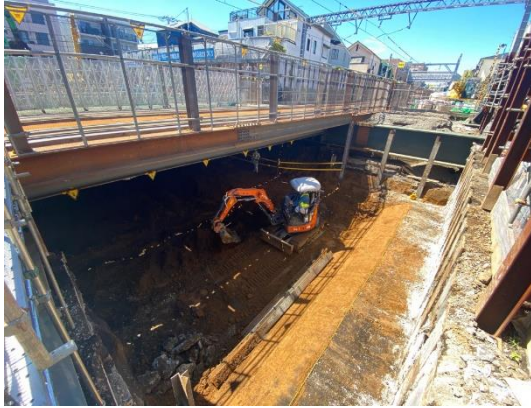
中井方取付部 掘削工事
