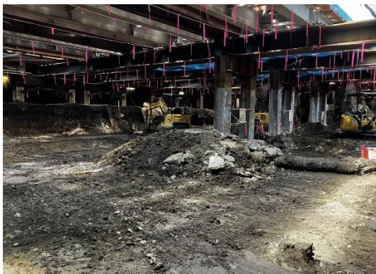
沼袋駅部 掘削工事
