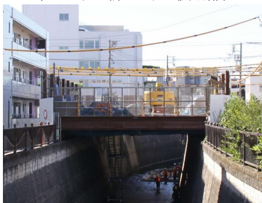
妙正寺川横断部 地盤改良工事
