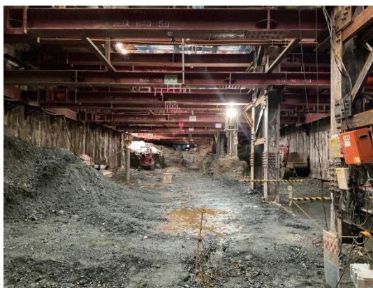
野方方取付部 掘削及び山留支保工設置工事
