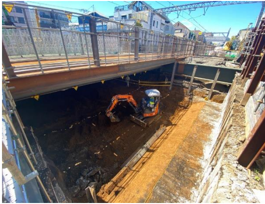
中井方取付部 掘削工事
